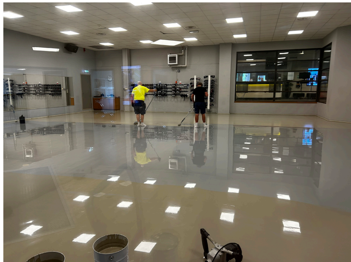
Golvrenovering i Lilla Salen, Friskishuset
